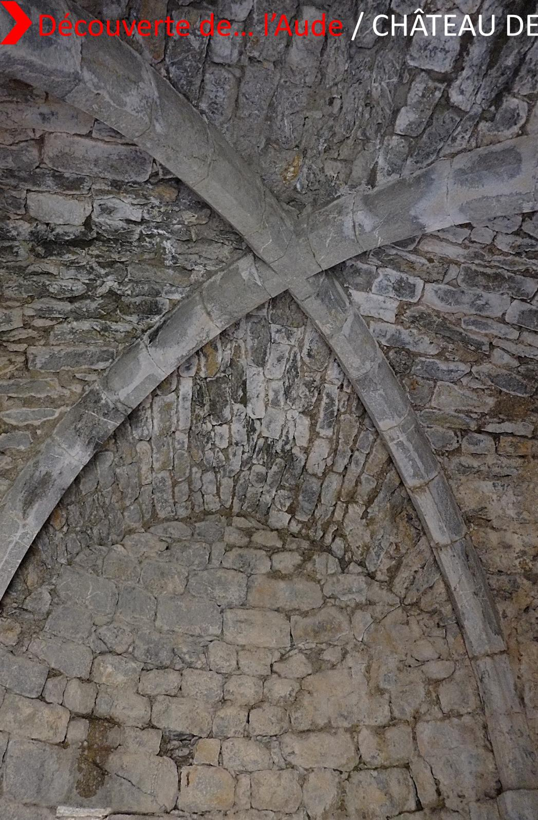
La tour de la dame Blanche comprenait 3 niveaux. Elle possède une salle basse voûtée sur une croisée d'ogives, dont la clef de voûte n'est pas ouvragée. A l'entrée, à gauche, un petit conduit est creusé dans la paroi : il s'agit d'un porte-voix qui permettait de communiquer d'un étage à l'autre.
